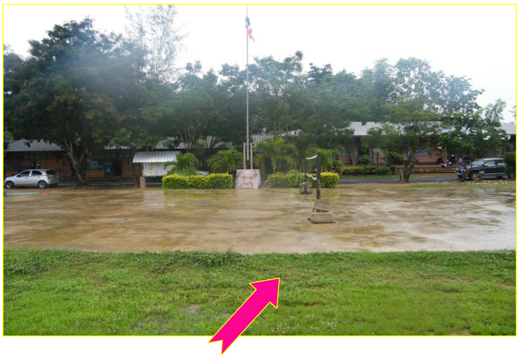
ลานกีฬาอเนกประสงค์ในโรงเรียนบ้านโนนสูงน้อย ขนาดกว้าง 13 เมตร ยาว 22 เมตร หนา 0.08 เมตร พื้นที่ใช้สอยไม่น้อยกว่า 286 ตารางเมตร
